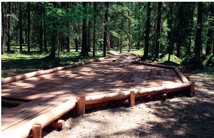
Ил. 8. «Командный пункт Западного фронта»: фрагмент реконструкции «колейной» дороги с «карманом» для разъезда легковых автомашин. Фото В.П. Новикова
