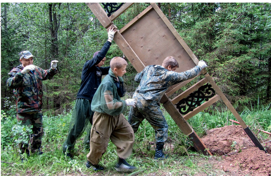
Работы по обустройству маршрута «Тропа предков»
