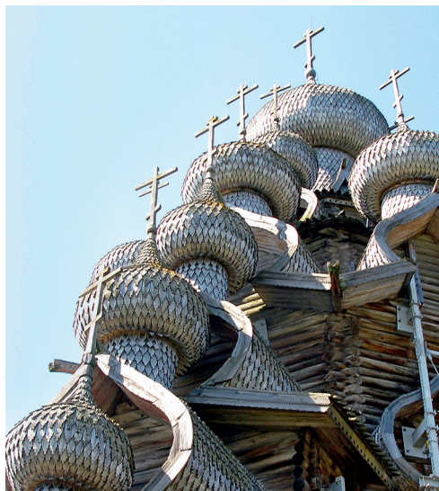
Ил. 1. Церковь Преображения (Кижы). Фрагмент кровли. Фото П. Жукова. 2010 г.
